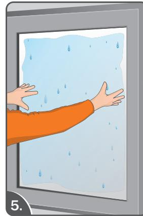
Legen Sie die nasse Folie auf die nasse Glasscheibe. Die Folie lässt sich jetzt noch gut ausrichten. Vermeiden Sie die Folie abzulösen, da sich dadurch Schmutz zwischen Scheibe und Folie legen kann.
